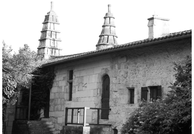
La Maladrerie de Périgueux
