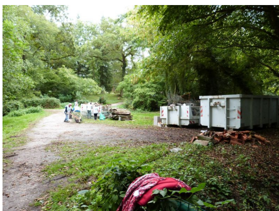
Travaux de nettoyage
